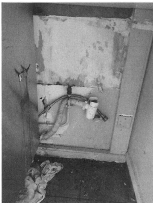
Ballon sous évier déposé et condamné
