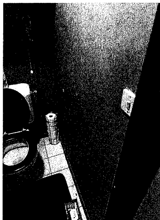
Pas de fuite apparente dans le logement situé au-dessus
